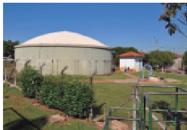
Reservatório de água do SAAEI - Jardim 2000
