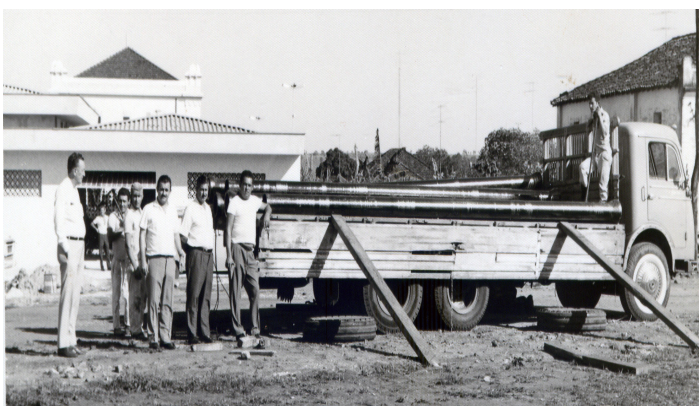
Administração 1969/1972 - Chegada dos tubos para canalização de água.
