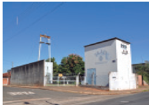
Poço profundo do SAAEI - Jardim Primavera
