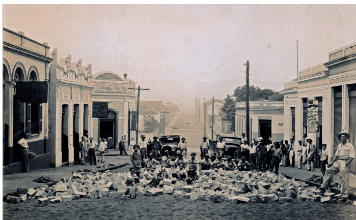
Calçamento em paralelepípedo da Av. XV de Novembro (Pres. Valentim Gentil) entre as Ruas José Bonifácio (José Trevisan) e Pe. Tarallo
