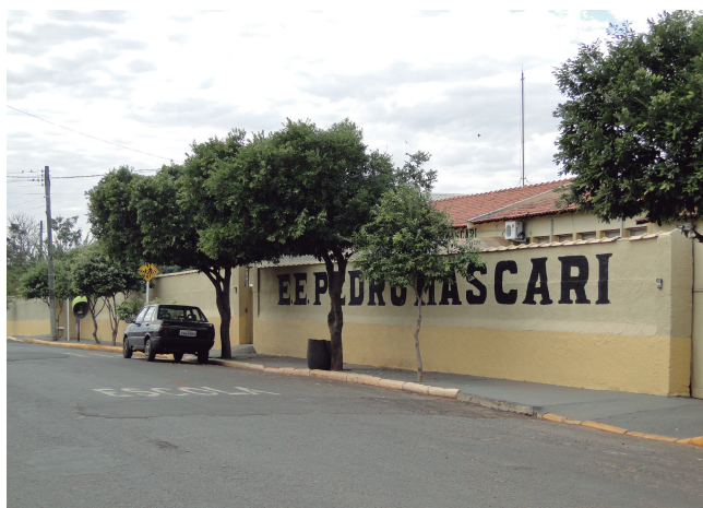
Prédio da EE Pedro Mascari, no Distrito de Nova América
