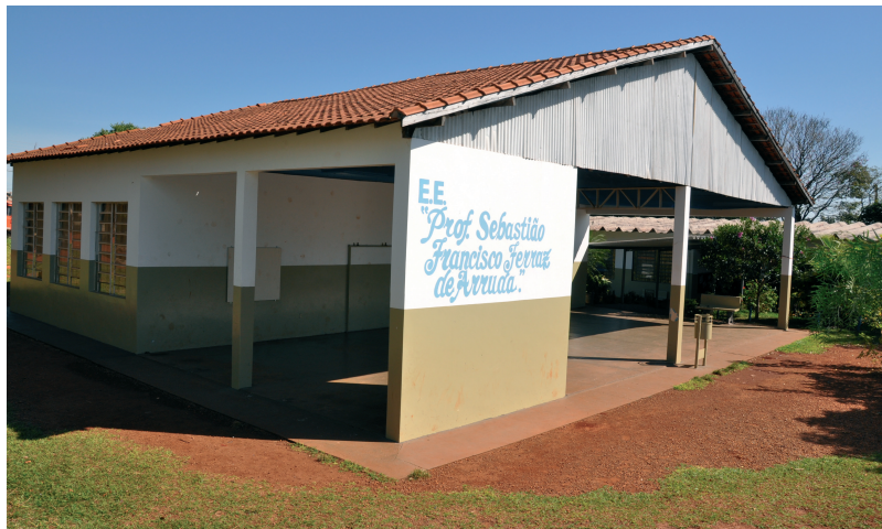
Galpão coberto da EE Prof. Sebastião Francisco Ferraz de Arruda - Jardim 2000
