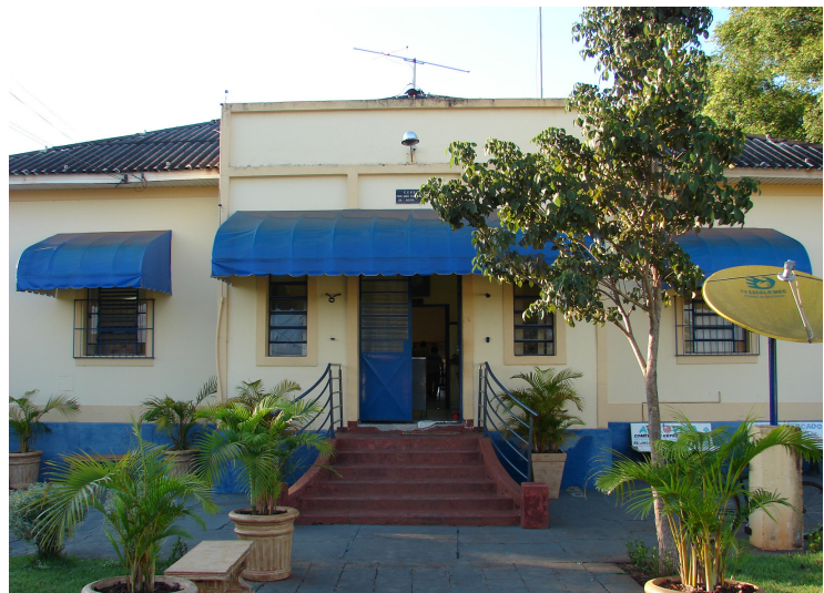
Fachada da EE João Caetano da Rocha, no Distrito de Tapinas
