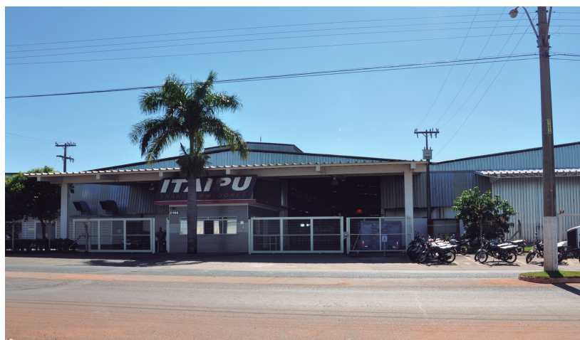
Instalações da Itaipu Transformadores, no Distrito Industrial II
