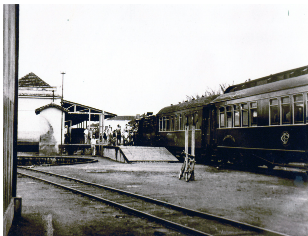
Plataforma de embarque da Estação de Ferro Douradense
