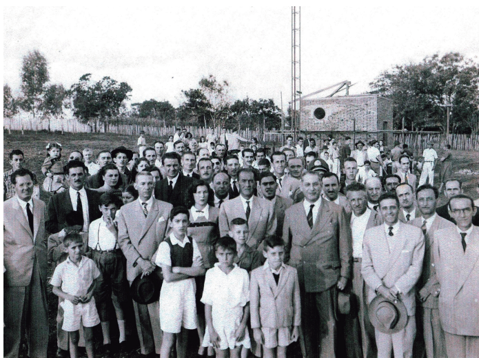
Inauguração da torre de transmissão da Rádio Difusora de Itápolis, instalada no Largo São Bento, local onde hoje estão instalados os clubes: Rotary Clube, Lions Clube, Centro Espírita Nova Era, Loja Maçônica Dr. João Carlos Ferraro e outros.
