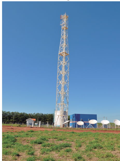
Torre do novo complexo de transmissão de TV
