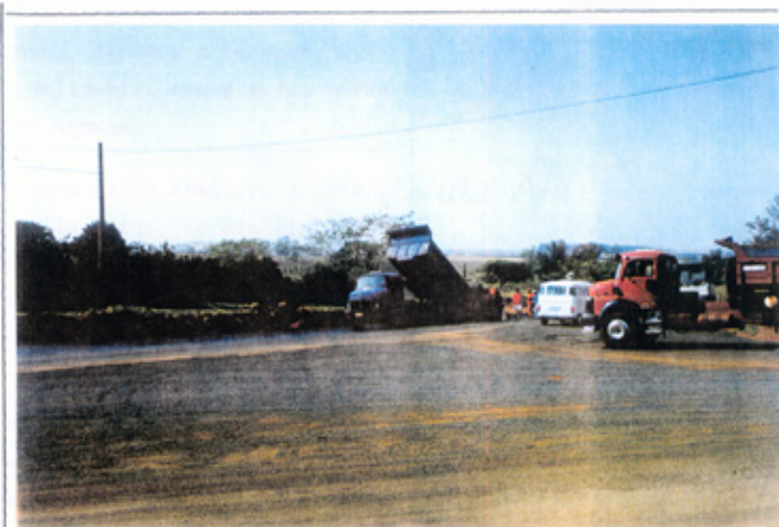
Foto: (15/09/99) A Companhia de asfalto, responsável pela pavimentação, (SPEL) desenvolvendo seu trabalho num trecho da estrada.
