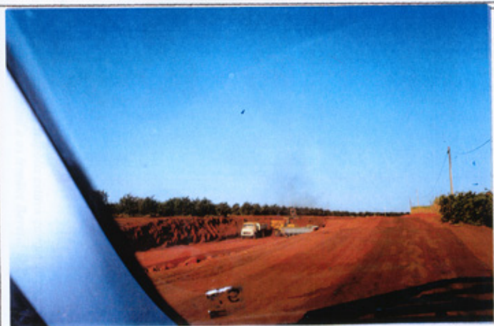
FOTO A ESQUERDA; Maquinas da Prefeitura de Itápolis, trabalhando no alargamento e terraplanagem da estrada- Itápolis - Quadro, no início de ABRIL - 97.
